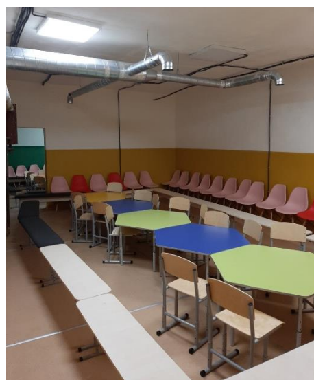
Відремонтоване укриття в Стольненському ЗЗСО І-ІІІ ст.
